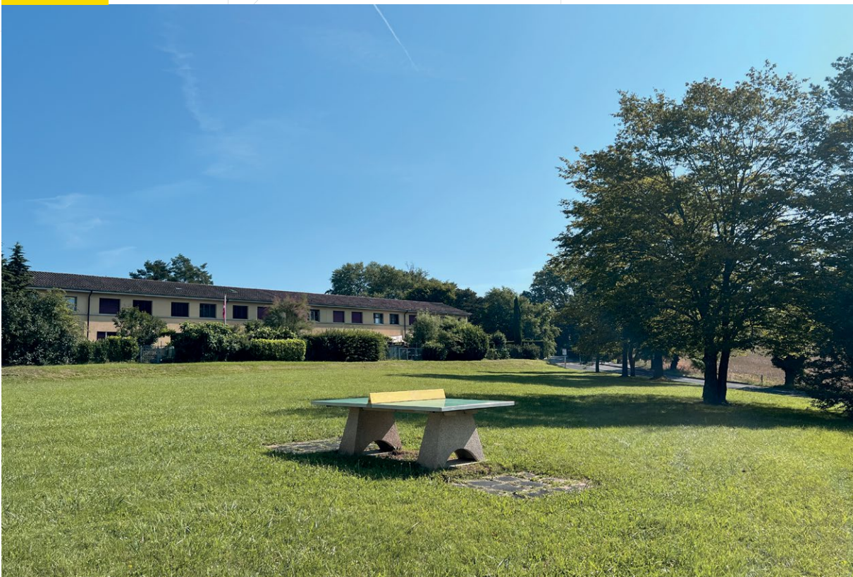
Immeubles route d’Epeisses 1 – 27.
