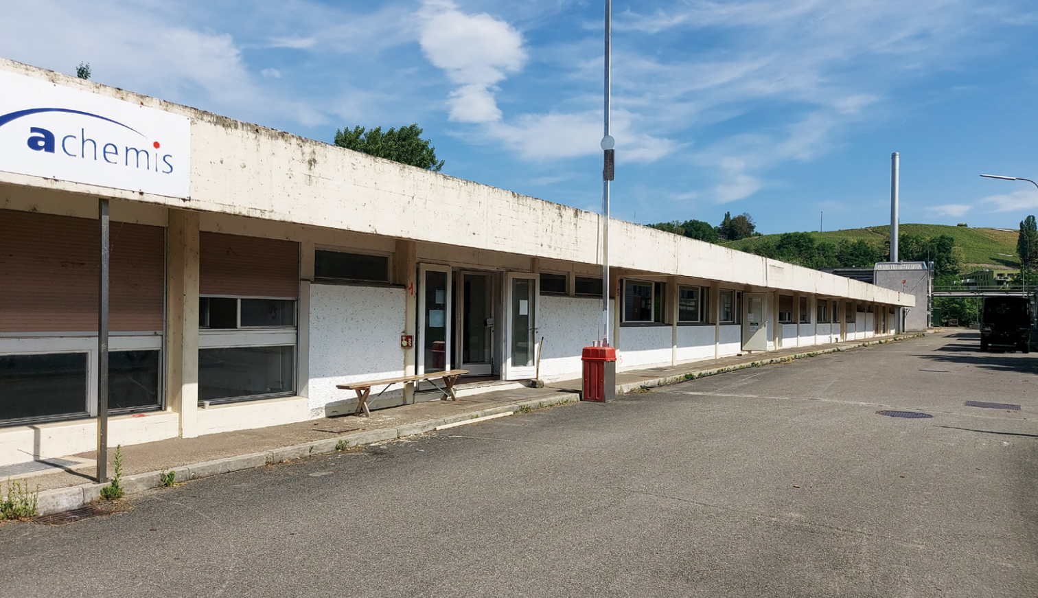
Usine désaffectée à la Touvière
