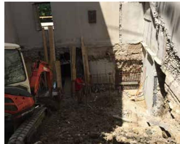
Creuse en sous-œuvre pour création d'un sous-sol abritant une partie des installations techniques des bâtiments et création d'une liaison avec le nouveau parking souterrain.
